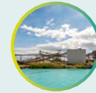
LGR Jupiter (grindinstallatie) 100% elektrisch
